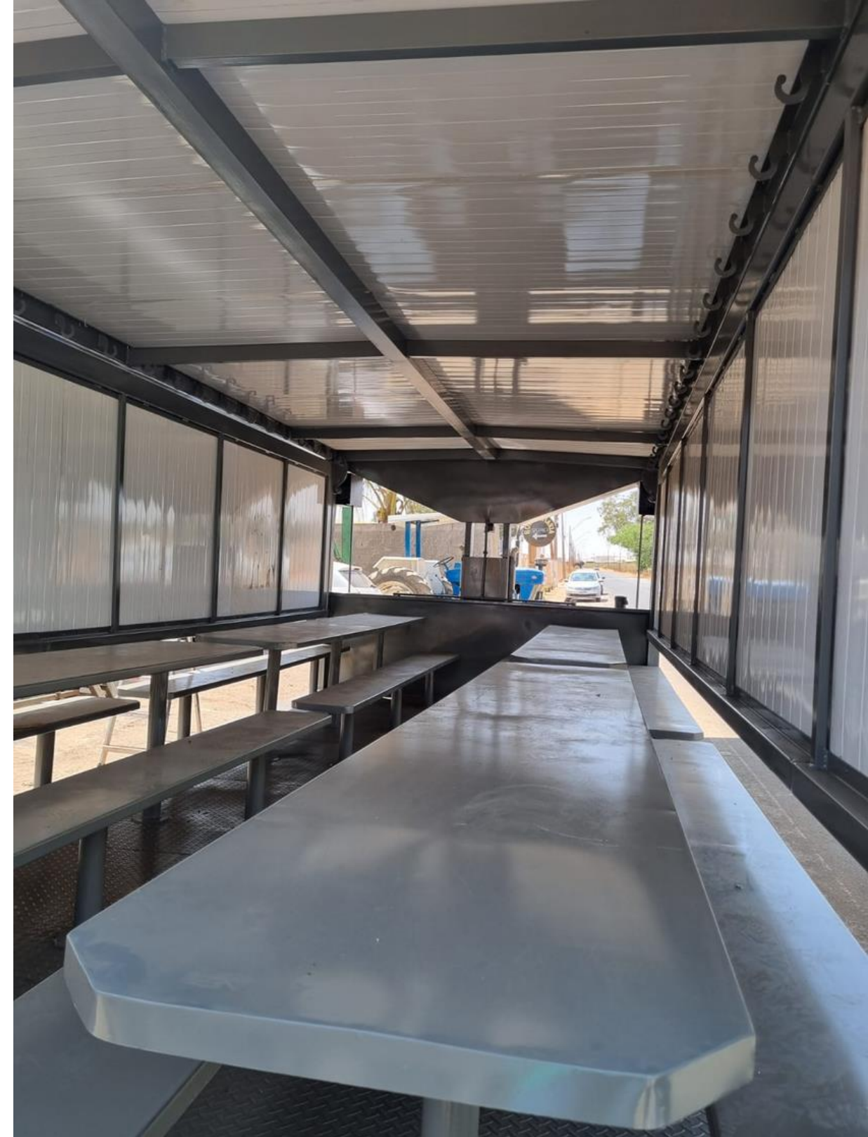
Refeitórios de campo com telhas térmicas.
